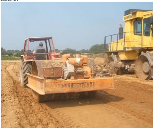
Slika 3. Prijelaz valjka preko zemljane ispune
