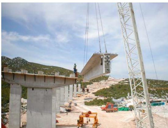
Slika 7. Montiranje glavnog nosača auto dizalicom
