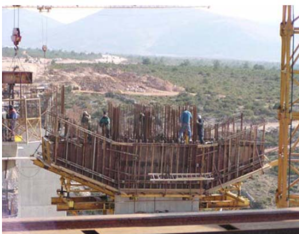
Slika 5. Izvedena skela i oplata naglavnice
