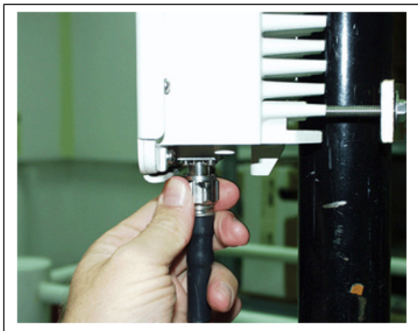
Slika 8. Spajanje koaksijalnog kabla na sektorsku antenu
