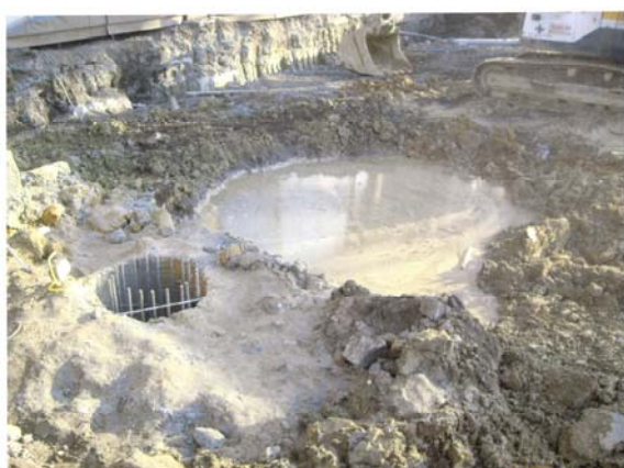
Slika 8. Izvedeni CFA piloti u tlu
