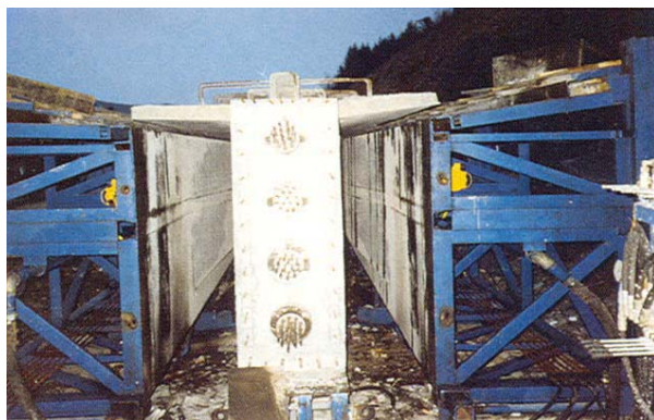
Slika 6. Izbetonirani nosač u kalupu
