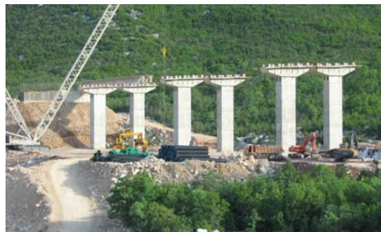
Slika 1. Montaža stupova i upornjaka
