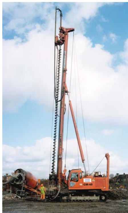
Slika 1. Bušuća garnitura za CFA pilote
