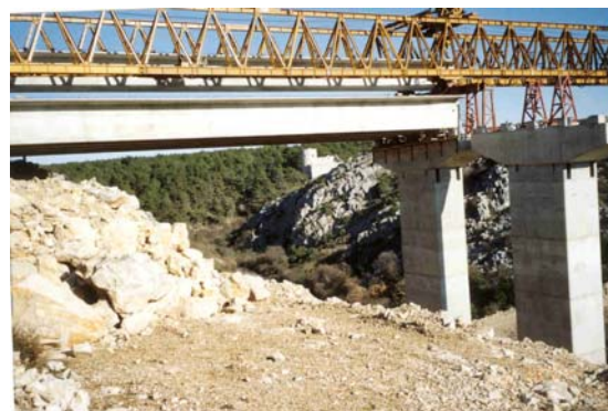
Slika 8. Montiranje glavnog nosača navlačnom skelom
